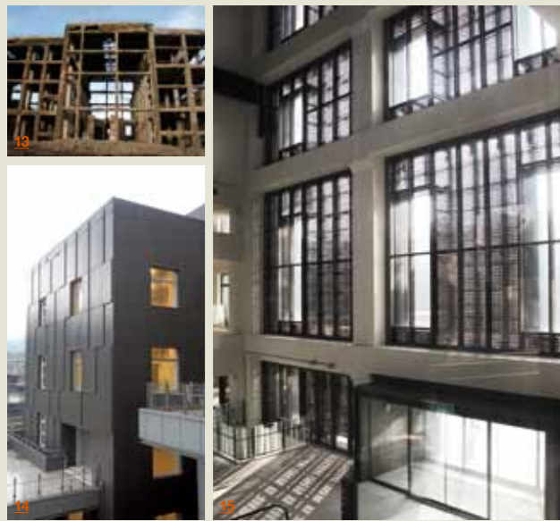
13 保留北火電廠大部分原有的鋼骨混凝土架構，維持歷史建築物的原始立面外觀開口分割 14,15 以沖孔板透光且不透明的特性，轉換建築物室內空間屬性，同時以深褐色的孔隙層疊外貌，訴說火力發電廠與煤礦的過往歷史
