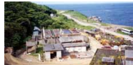
昔日單調令人不敢靠近的垃圾掩埋場與水肥處理廠（民國 88 年 8 月）。
