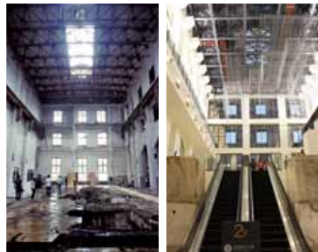
利用舊北火電廠發電機室挑空的空間作為主題館入口大廳，電動手扶梯兩旁未經整理的混凝土柱子，是原支撐發電機機座的兩座柱子。(左◎吳宜晏/右◎邱依婷)
