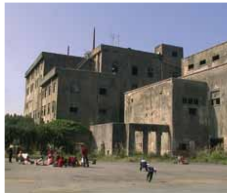
被指定為歷史建物的北火發電廠，處處可見深刻的時代軌跡。它的外表樸實無華，沒有太多裝飾；建築內部則採大尺度的空間規劃，搭配巨型的鋼製構架，是數十年前產業建築獨有的粗獷設計。(© 陳添喜)
